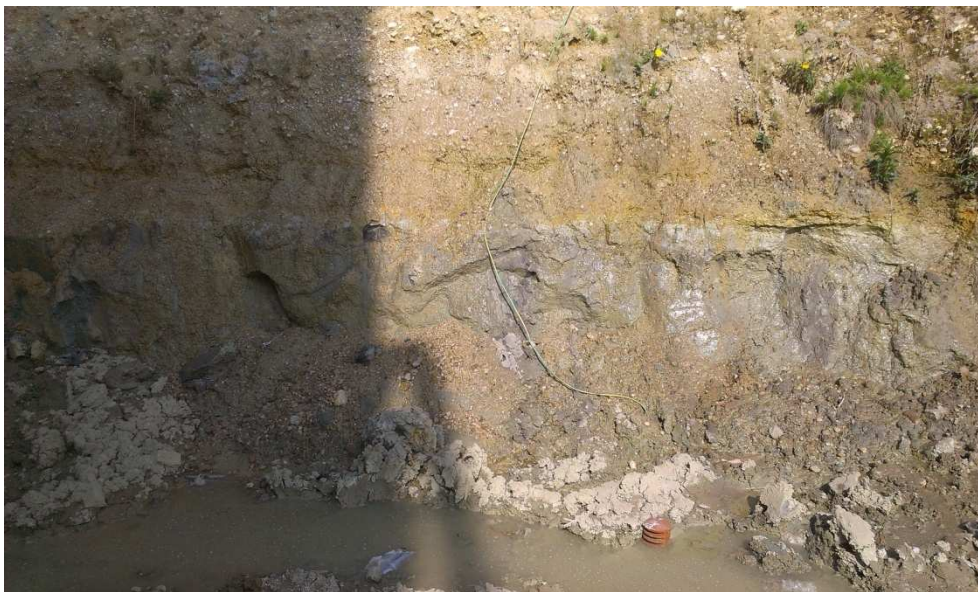
Facies marnoso-pelitica del MON 3 cartografata nella Carta Litologica come L-SUB-07 – Rocce tenere a prevalente coesione. E evidente come le acque meteoriche si infiltrano nel sedimento eluvio-colluviale sovrastante le rocce marnose per poi scorrere lungo l'interfaccia tra roccia e sedimento, a causa della bassa permeabilità delle rocce marnoso-pelitiche
