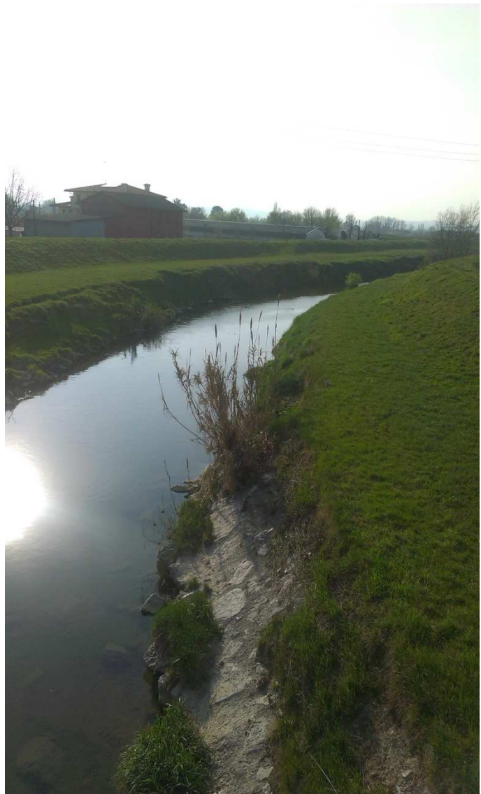
Argini artificiali lungo il torrente Monticano nella parte sud orientale del territorio comunale
