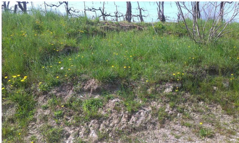
Esempio di nicchia di piccola frana (M-GRV-13) presente nella porzione collinare adibita a viticoltura
