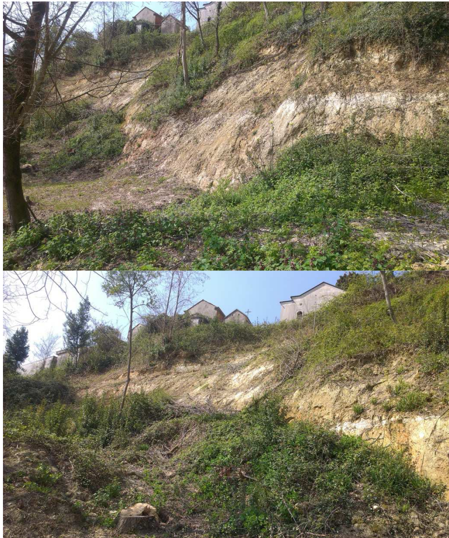
Nicchia (in alto) e parte sommitale del corpo di frana (in basso) del dissesto franoso in loc. S. Anna
