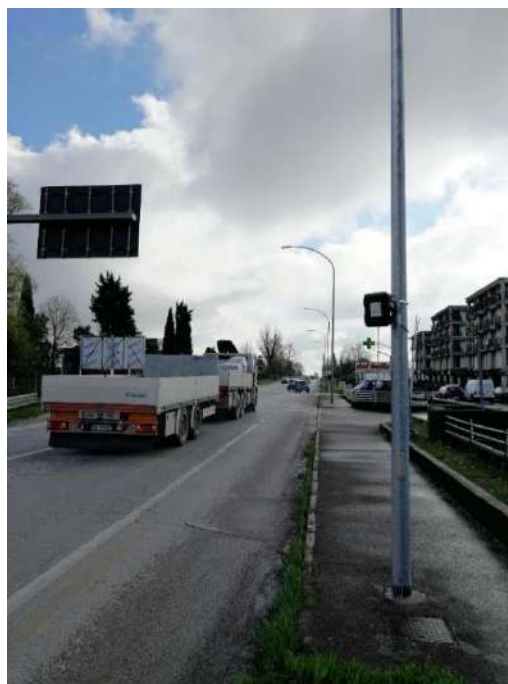
Figura 22: Esempio radar posizionato nella sezione S04 (viale Italia) in direzione San Fior
