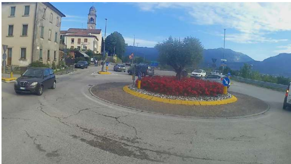
Figura 44 Rilievo nel nodo 49 (via Marcorà - via Cal delle Rive (Ogliano))
