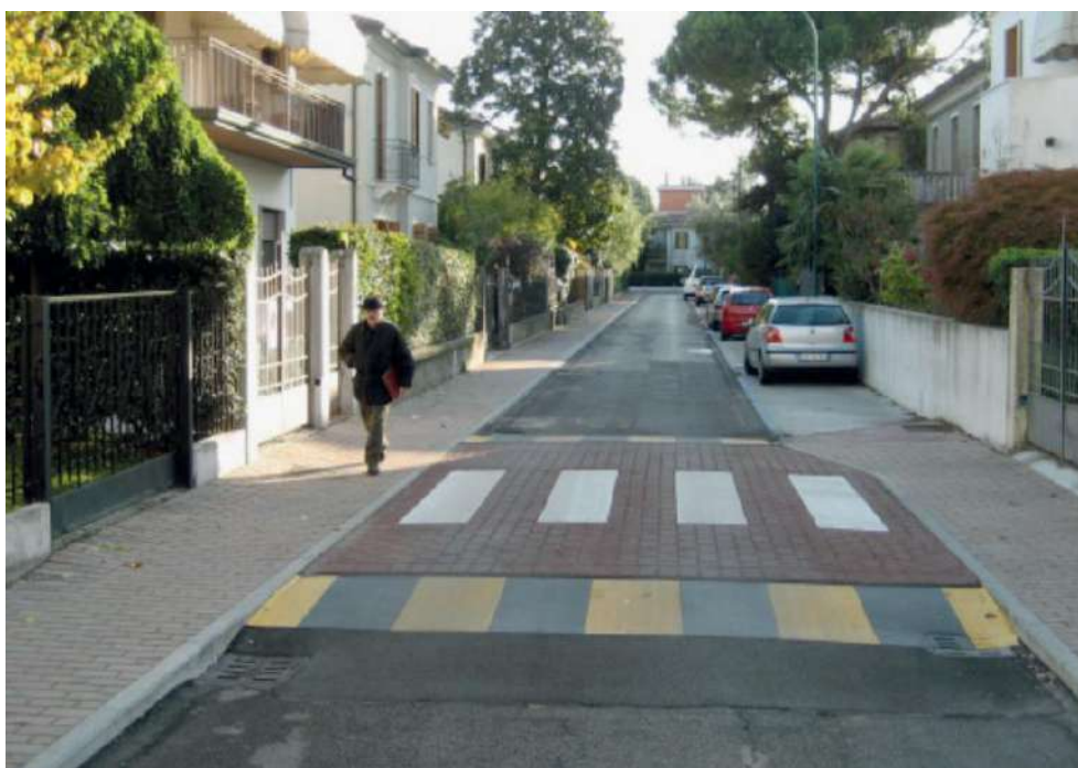
Figura 39: Attraversamento stradale rialzato
