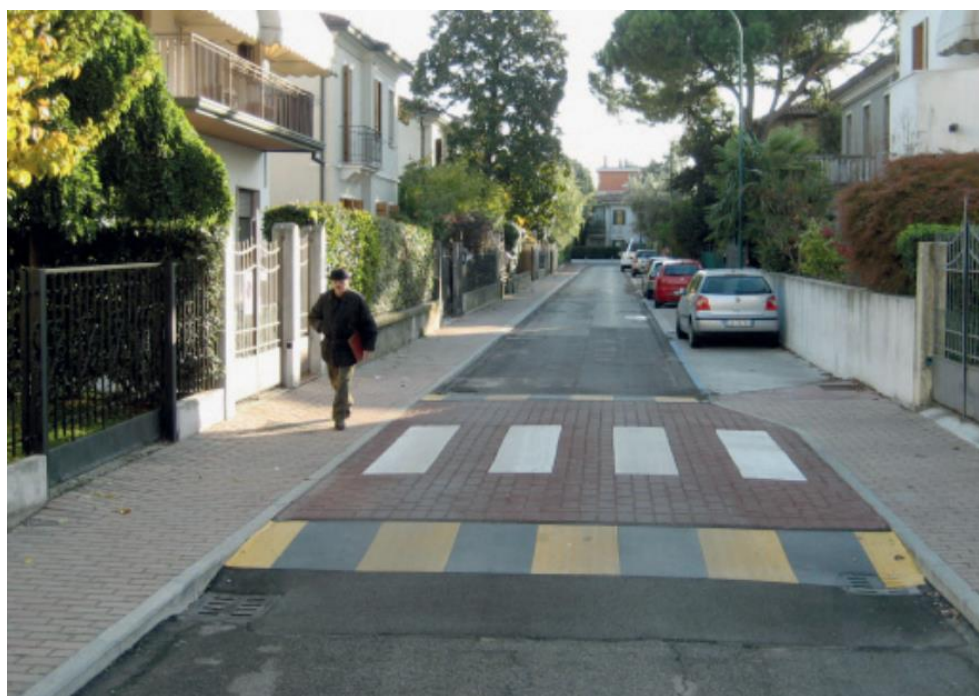
Figura 39: Attraversamento stradale rialzato
