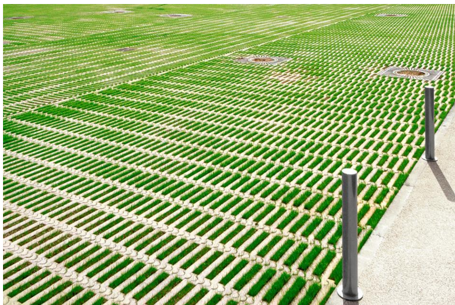
Esempio pavimentazione area parcheggio e marciapiede
