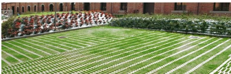
Esempio aree verdi rialzate rispetto al parcheggio verso la carreggiata stradale
