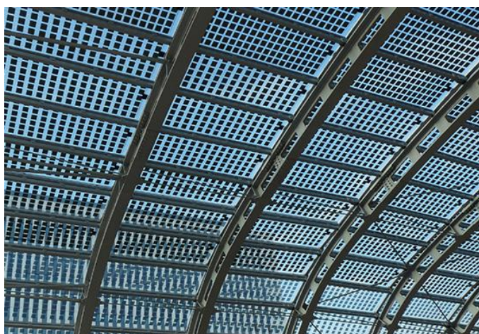
Esempio di vetri fotovoltaici in copertura
